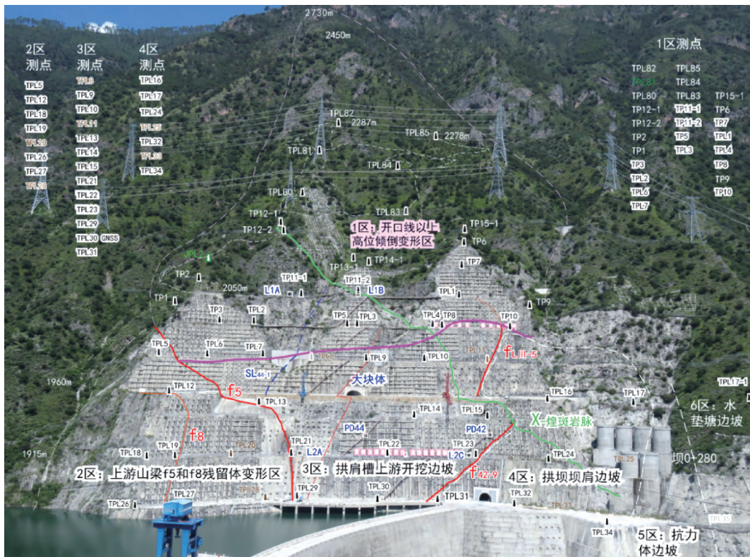
图 1 左岸边坡分区及表观监测布置
